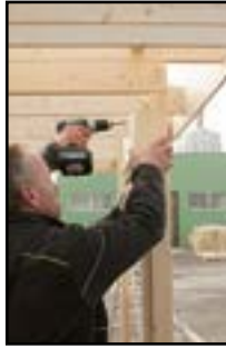
Anschauben der Führingleiste für Geschlossene Wand
