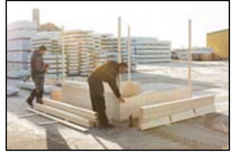
Anbringen der gesamten Wandbohlen
