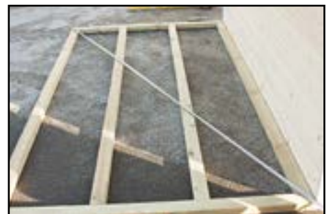
Diagonale vom Fundament kontrollieren
