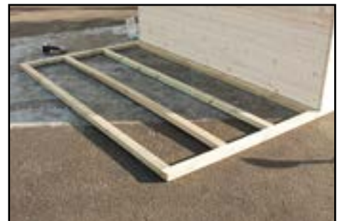
Auslegen von den Fundamenthölzern
