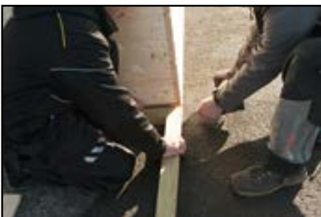
Verschrauben der Fundamenthölzer
