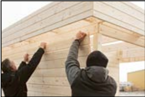
die letzten 4 Bohlen zusammen einsetzen und dann erst verschrauben
