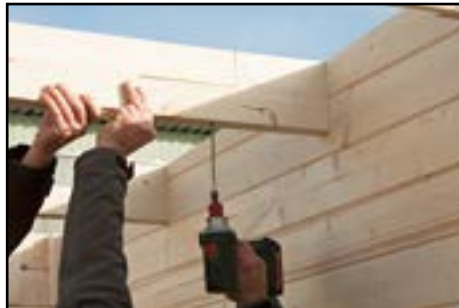
Auflegen und befestigen der Dachsparren
