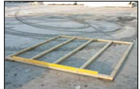
Kontrolle ob Fundamenthölzer in Waage
