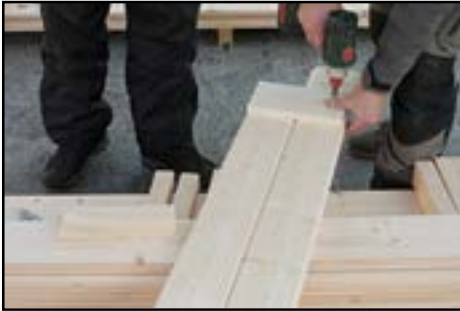
Verschrauben der Wandverlängerung
