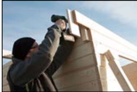
Montage der Wandverlängerung (vorne) nach technischen Daten
