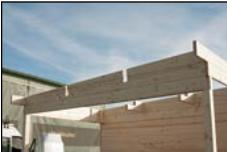
Seitenwand Montage Anbau
