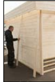
Abdeckleisten anbringen laut technischen Daten
