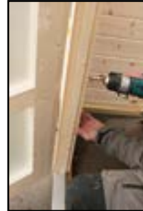
Befestigen vom Türrahmen mit den Türblindleisten innen
