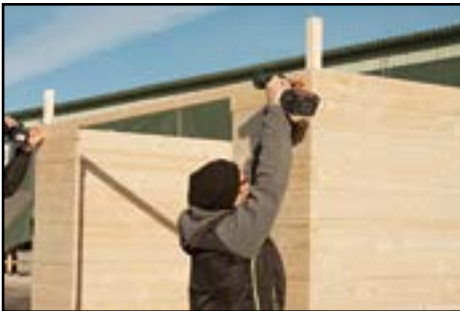
Anbringen der oberen Wandbohle (Tür)
