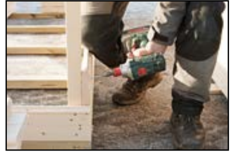
2. Bohlenkranz montieren
