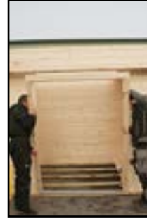
Einbau vom Türrahmen
