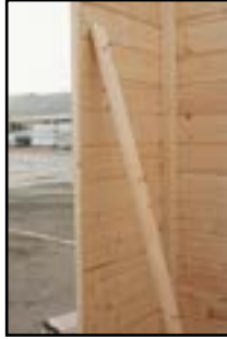
Bereitstellen der Türblindleisten
