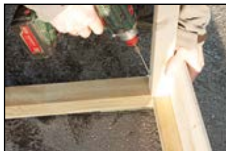
Eckkantholz am Fundament verschrauben
