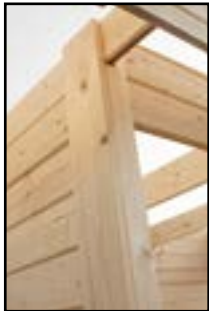
Abdeckleisten anbringen laut technischen Daten
