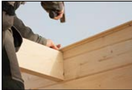
Anbringen der Dachbretter laut technischen Daten
