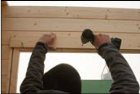
Befestigen vom Türrahmen mit den Türblindleisten aussen
