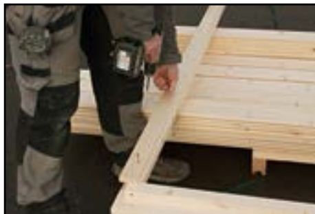
Verschrauben von dem Türrahmen
