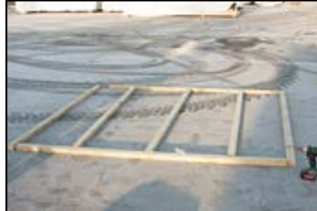
Fundamenthölzer auf gerades Fundament legen
