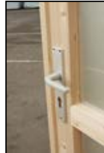
Anbringen der Drückergarnitur und Zylinderschloss
