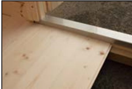
Fußboden im Haus einbringen, eventuell zuschneiden und befestigen
