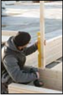
Kontrolle mit Wasserwaage ob im Lot
