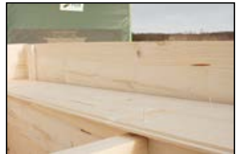
Auflegen der Dachbretter
