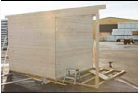
Montage Stützpfosten
