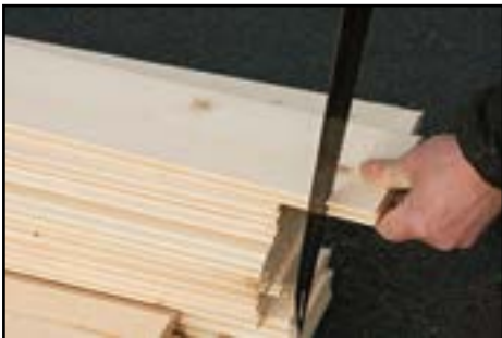
Dachbretter zuschneiden laut technischen Daten
