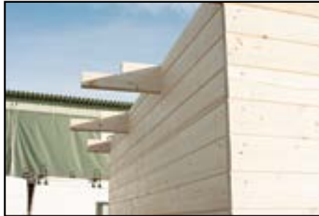
Dachsparren einlegen achten Sie auf technische Daten
