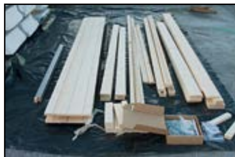
Vorbereitung und Kontrolle der einzelnen Bauteile
