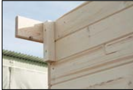
Montage der Wandverlängerung (hinten) nach technischen Daten
