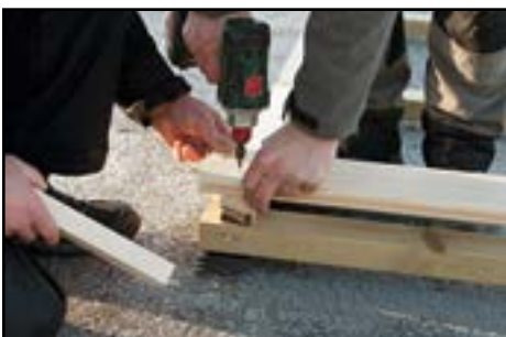
1. Wandbohle am Eckkantholz vorbohren und verschrauben
