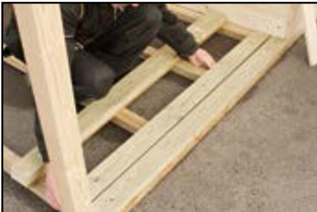
Verlegen und befestigen der Terrassenbretter
