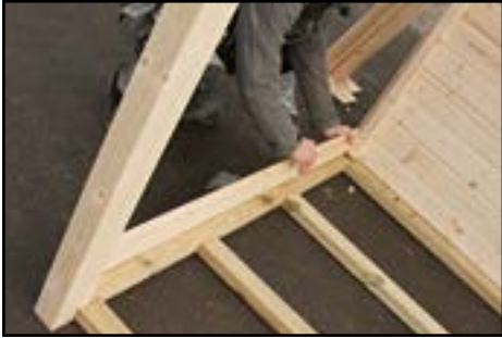
1. Wandbohle in Waage ausrichten
