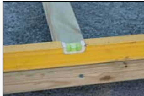
Kontrolle ob Fundamenthölzer in Waage
