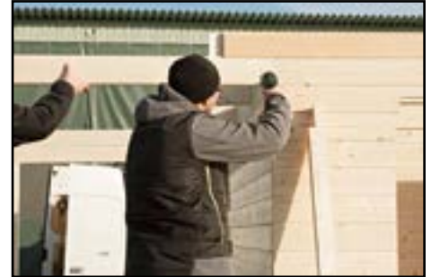
Montage der Wandverlängerung (vorne) nach technischen Daten
