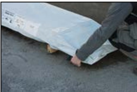
Öffnen von dem Paket Terrassenfußboden und Seitendach
