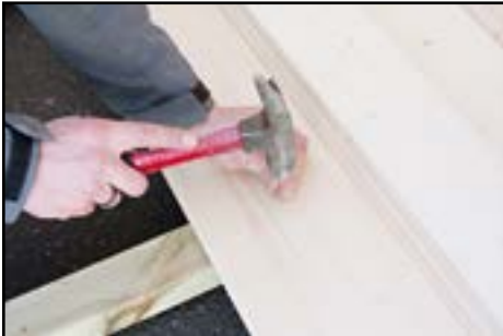
Fußboden im Haus einbringen und befestigen
