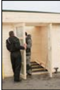
Einhängen der Türen und justieren
