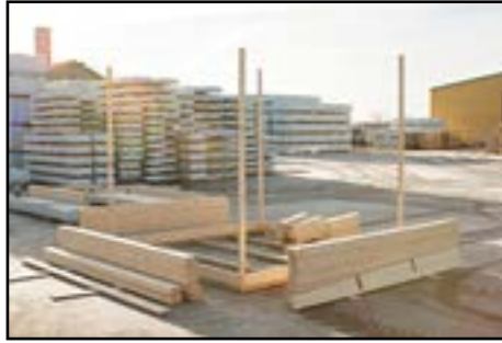
Vorbereiten der passenden Wandbohlen
