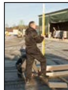
Eckkantholz in Waage ausrichten
