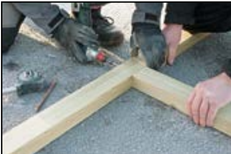
Fundamenthölzer verschrauben
