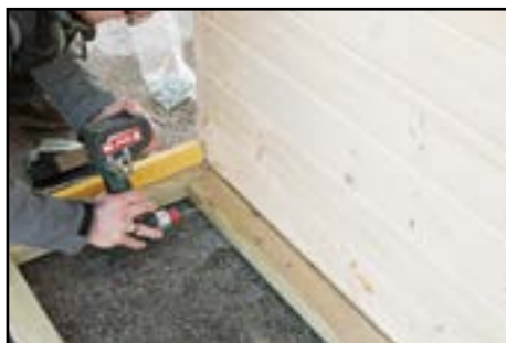
Kontrolle ob das Fundament in Waage liegt
