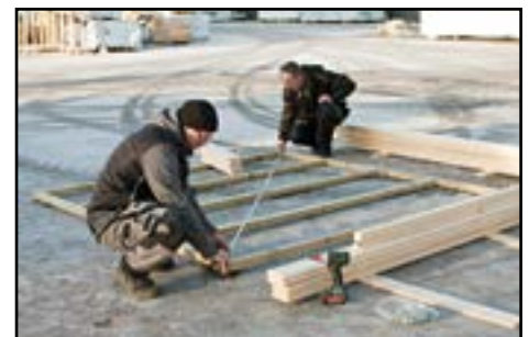
Diagonale vom Fundament kontrollieren
