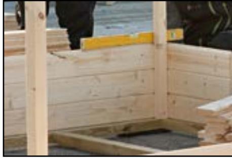
Kontrolle mit Wasserwaage ob in Waage
