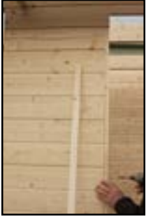
Türleisten anbringen laut technischen Daten
