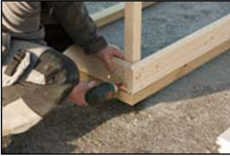
Verschrauben der Wandbohlen an den Eckkanthölzern
