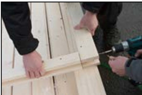
Verschrauben von dem Türrahmen
