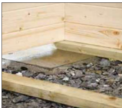
Schotterbett mit Gehwegplatten als Minimaluntergrund für die Errichtung eines Gartenhauses
