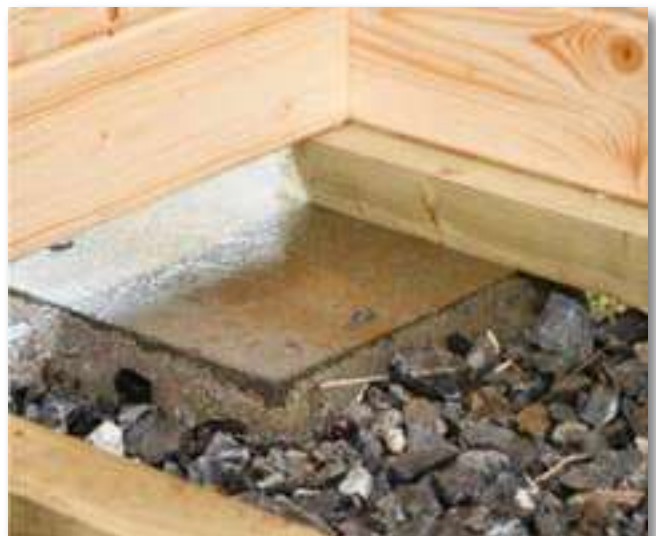
Verdichtetes Schotterbett mit Gehwegplatten als Minimaluntergrund für die Errichtung eines Hauses.
