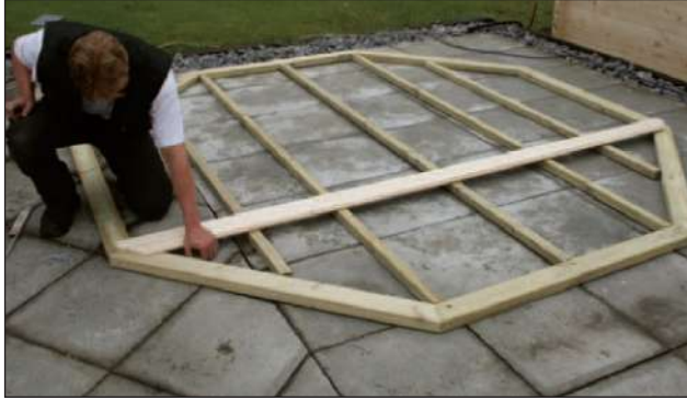
Abb. 11 Die Fußbodendielen sind bereits auf Maß geschnitten und brauchen nur bündig mit der äußeren Kante verlegt werden.
