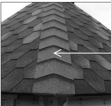
Ansicht Dachgrat fertig montiert
