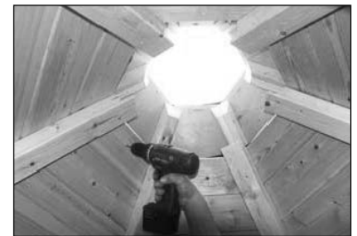
Dachhaube von innen mit Schrauben befestigen
