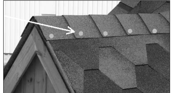
Schindel mit Dachpappennägel befestigen
